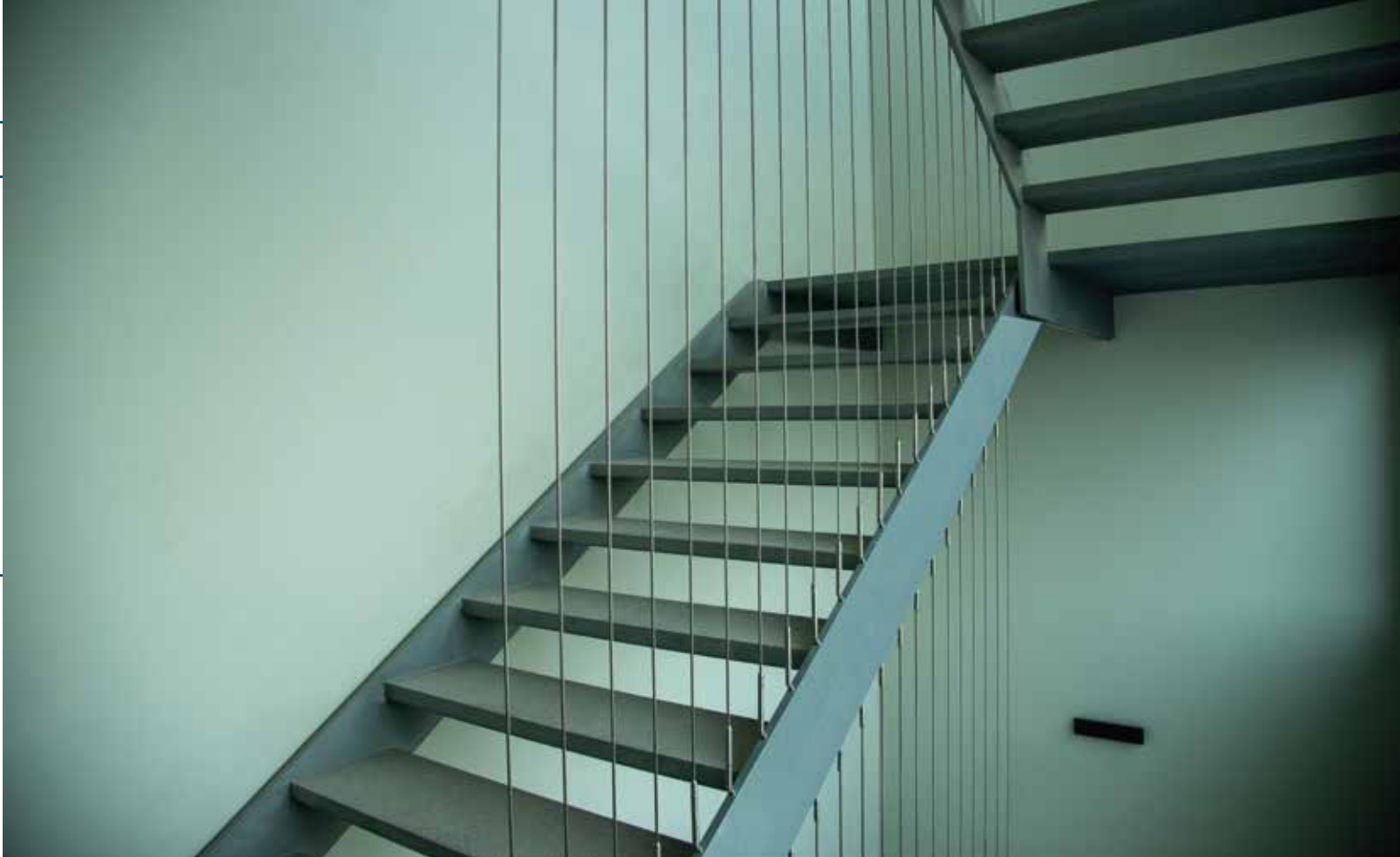
اتصال هندریل کابلی W601
